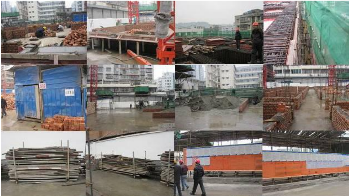
图2 施工现场例图②
