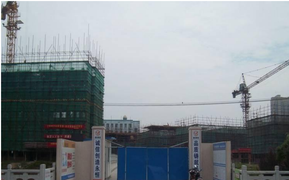
图 1 施工现场例图
