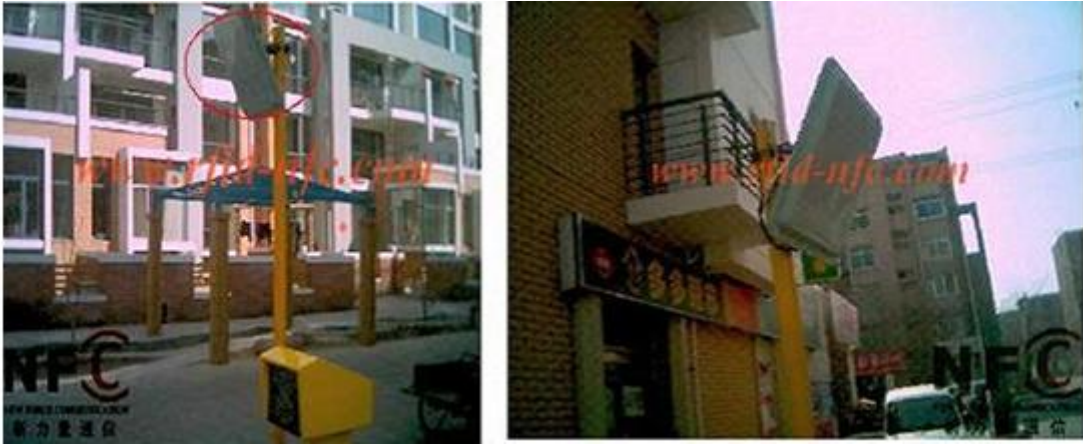
图 7：读写器安装现场图
